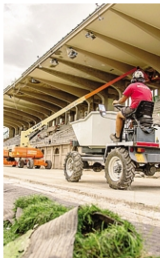
Il cantiere del 2015
